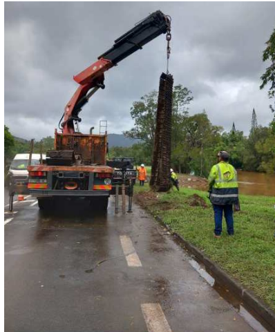
Enlèvement des déchets, nettoyage de la zone
